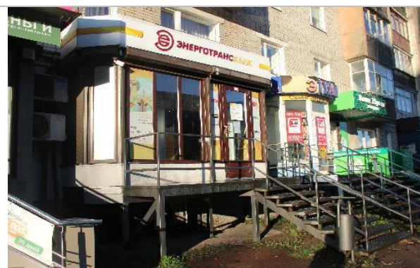
Фотография 3.1. Внешнее состояние объекта
