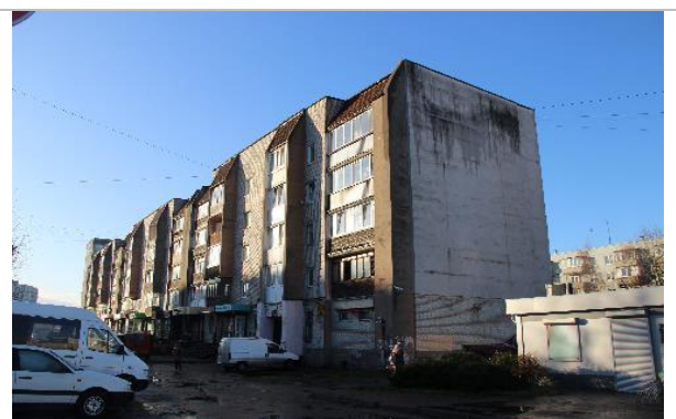
Фотография 3.2. Внешнее состояние объекта
